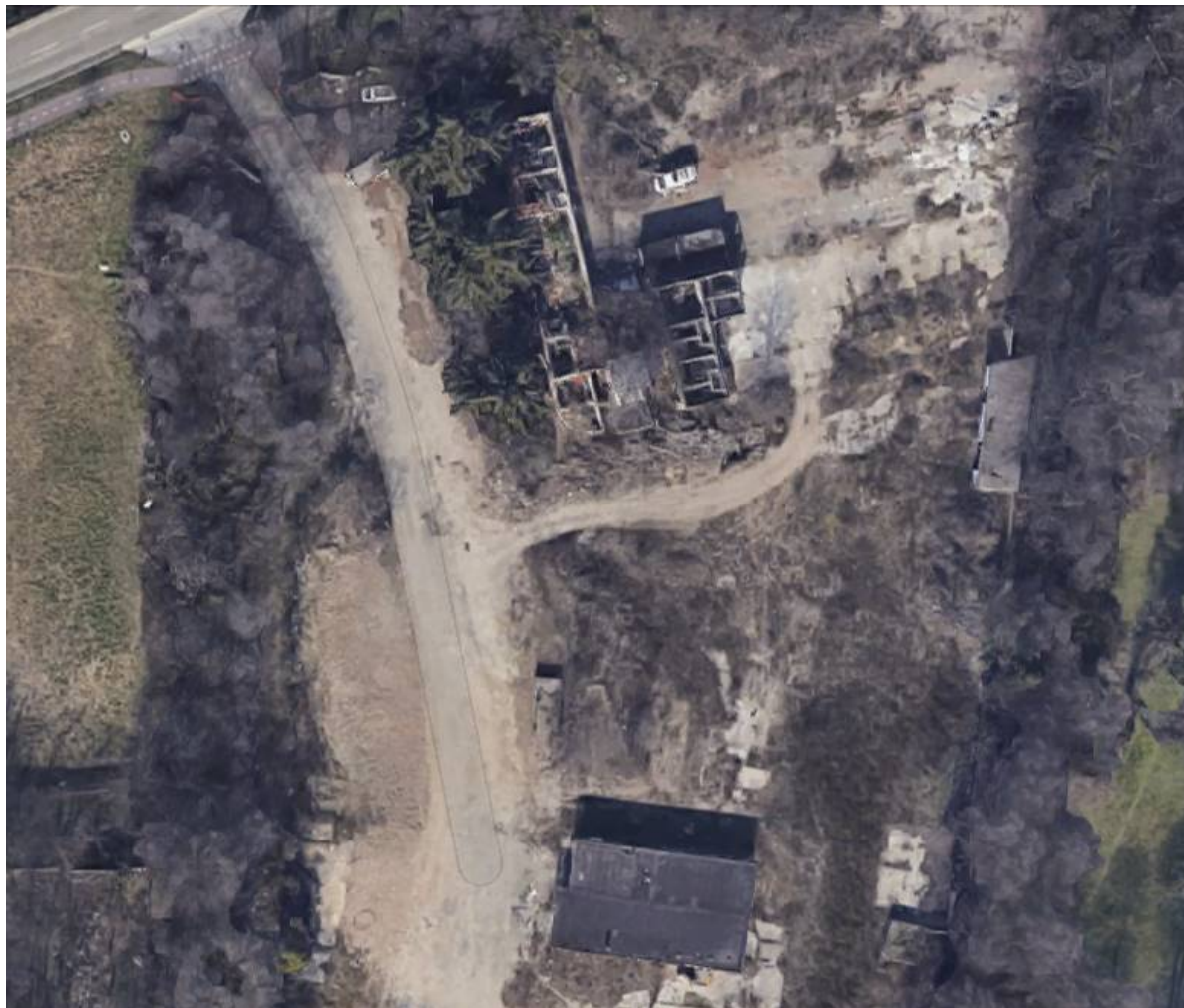
Figura 2 Ripresa area dell'area (inizio 2022) ove è evidente lo stato di degrado
