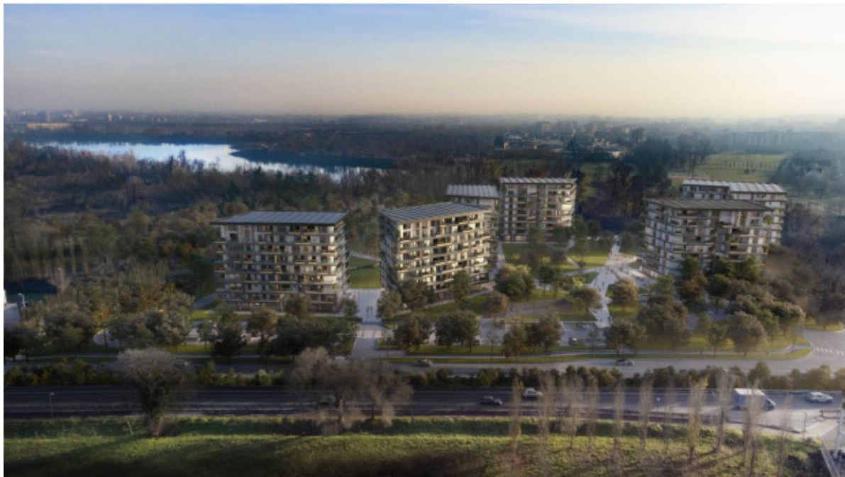
Figura 3 Vista complessiva dell'intero intervento da Nord (Strada Cassanese)
